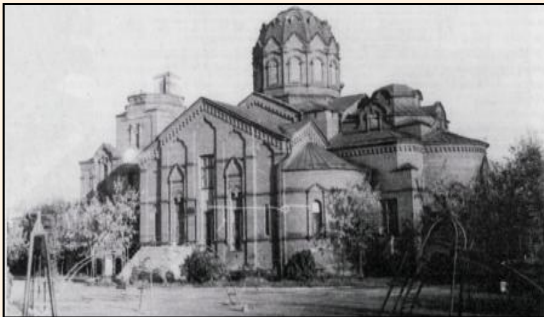
Церковь Александра Невского. ГЕЙЛЬ, В. Историко-архитектурный портрет Алого поля [Текст] / Вера Гейль // Челябинск. Архитектура. Строительство. Челябинск. 2006. – № 10 – С. 34.
